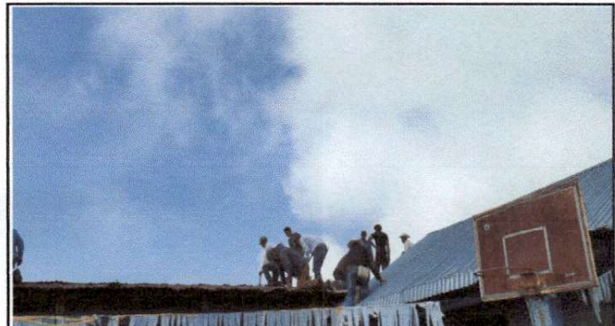
desmontaje de lamina en mal estado
