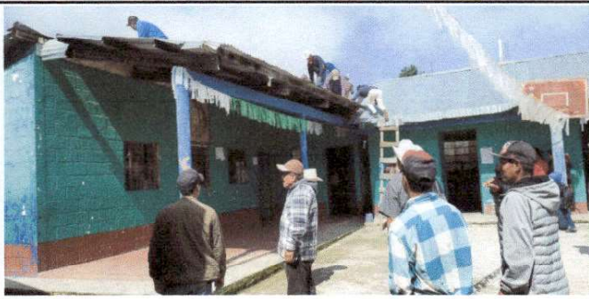
iniciando desmontaje de laminas
