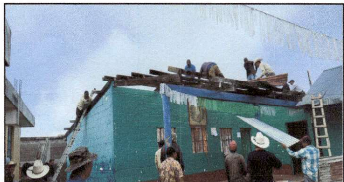
desmontaje de lamina en mal estado
