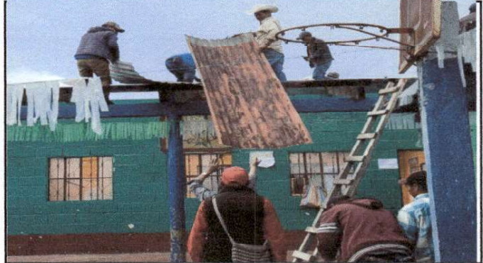
cambio de lamina por lamina troquelada
