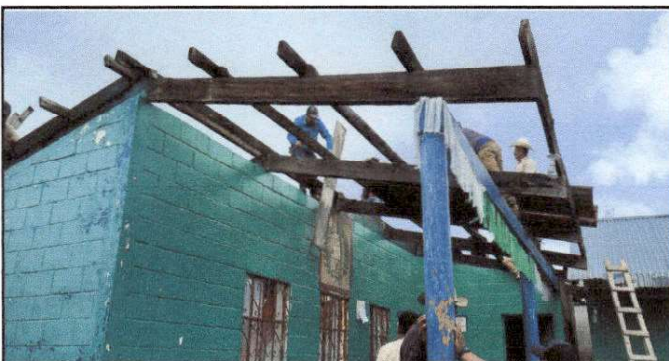
desmontaje de estructura de madera por costaneras metalicas
