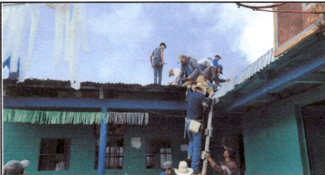
apoyo de padres de familia a albañil encargado de obra
